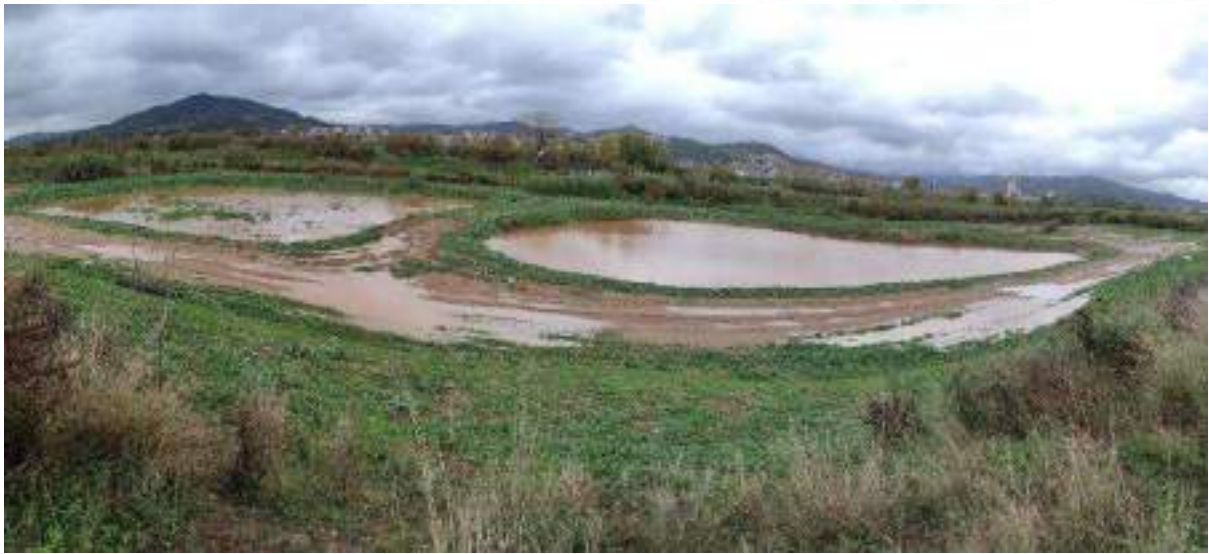
Figura 8. Imagen de la balsa 2 y 3 en explotación.
