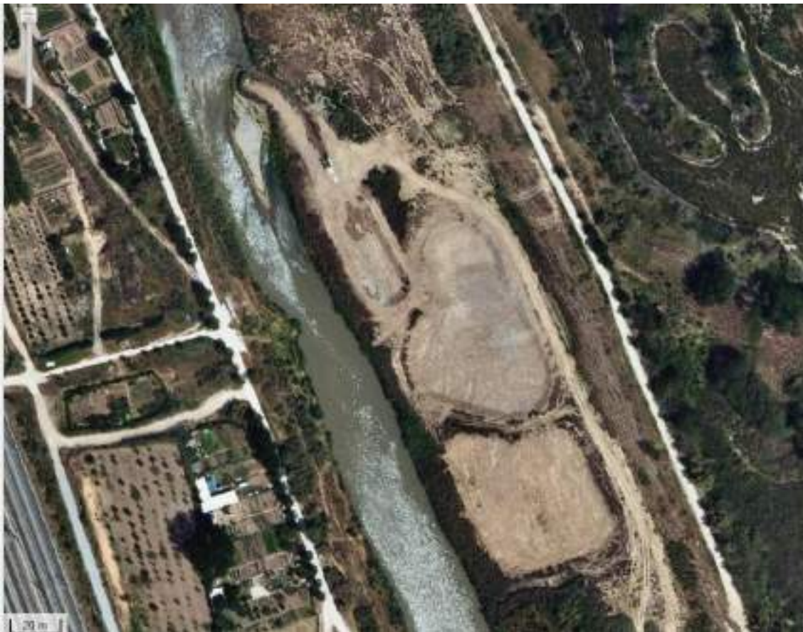
Figura 1. Foto aérea de las balsas de recarga de Molins de Rei en el acuífero del Llobregat ya construidas y previo a su puesta en marcha.
