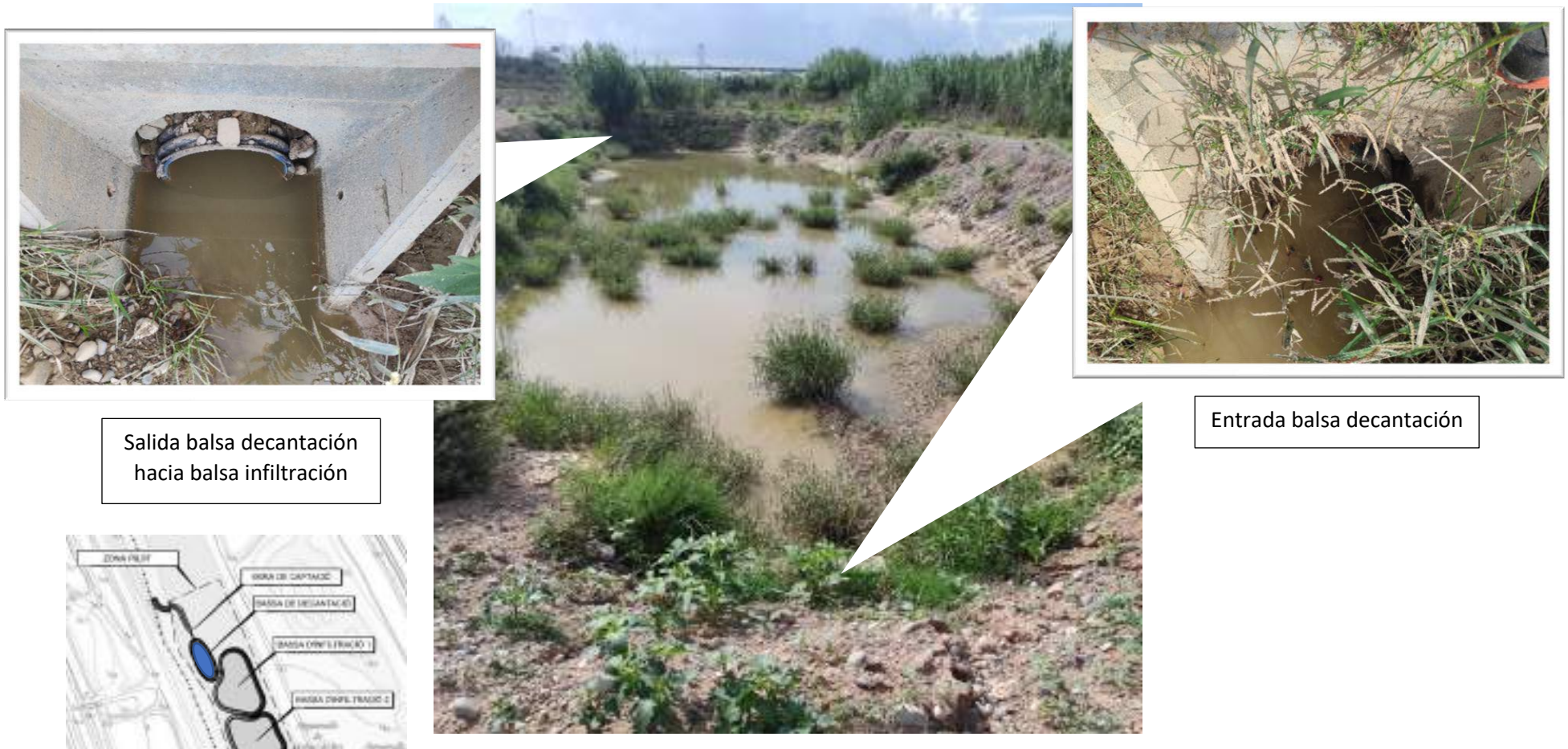
Figura 10. Detalles de la balsa de decantación
