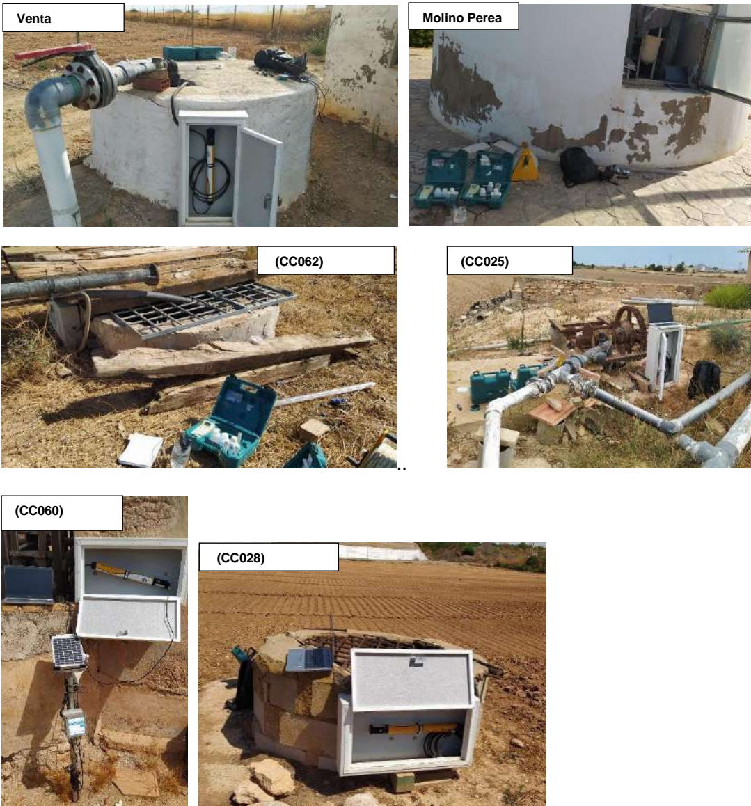
Figura 3. Estado de las instalaciones (06/09/2022)
