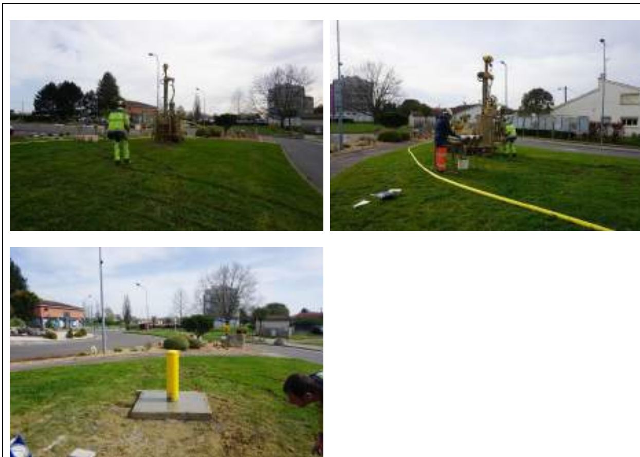
Illustration 15 – Réalisation du forage BSS004DFVR – Valence d'Agen
