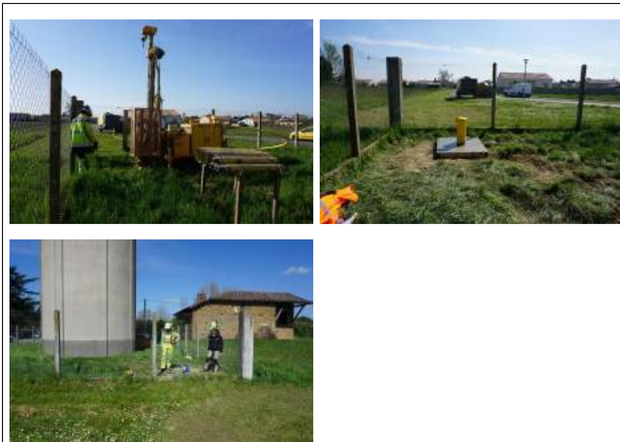
Illustration 9 – Réalisation du forage BSS004DFVQ - Finhan
