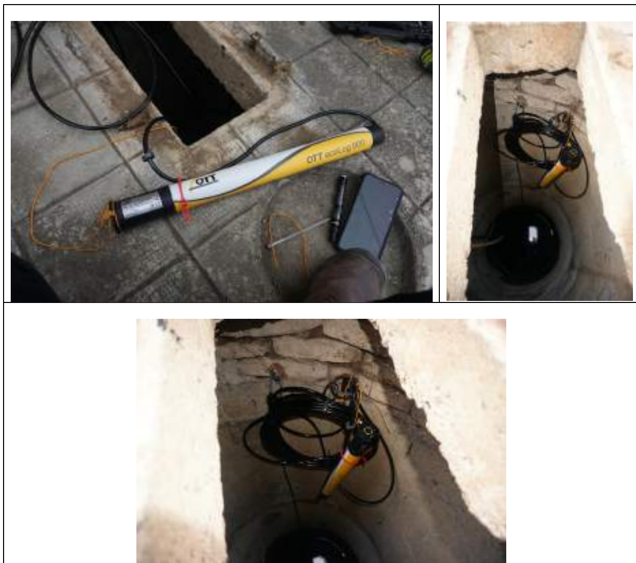
Illustration 20 – Installation de la sonde sur le point BSS002DCXR (Escatalens, Commune de Escatalens)
