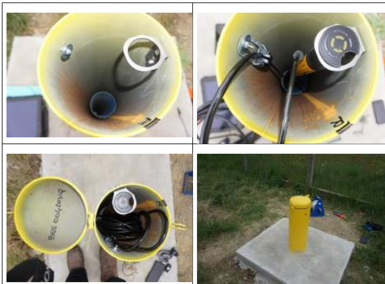
Illustration 22 – Installation de la sonde sur le point BSS004DFVQ (Finhan, Commune de Finhan)
