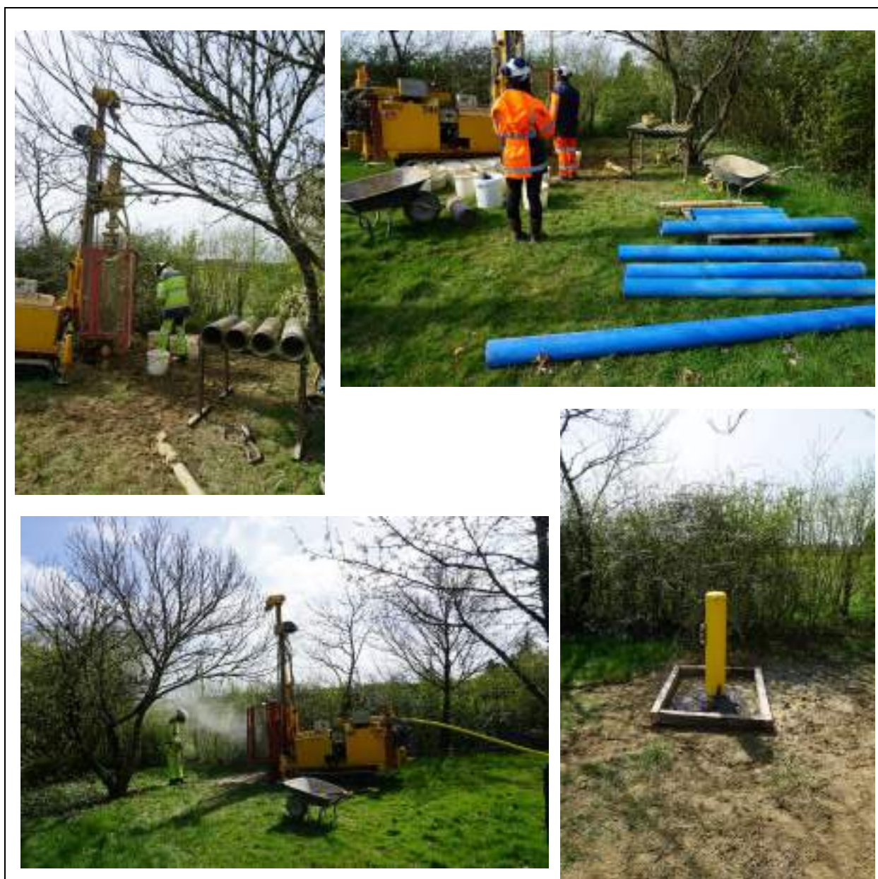
Illustration 6 – Réalisation du forage BSS004DFVG - Donzac
