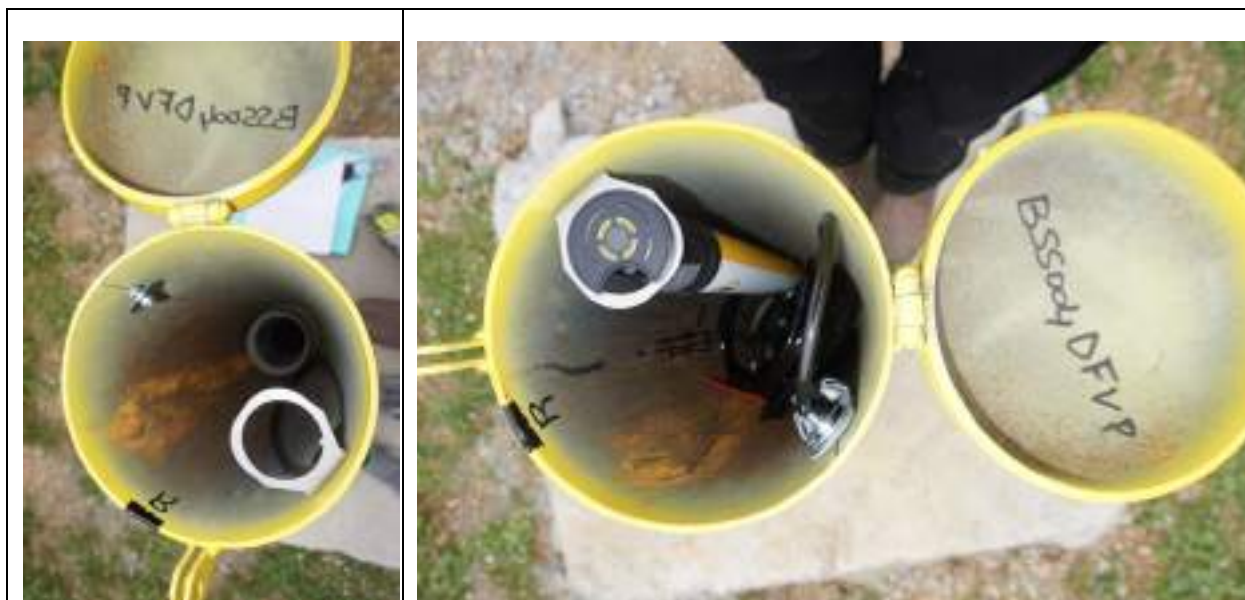
Illustration 23 – Installation de la sonde sur le point BSS004DFVP (Savenès, Commune de Savenès)
