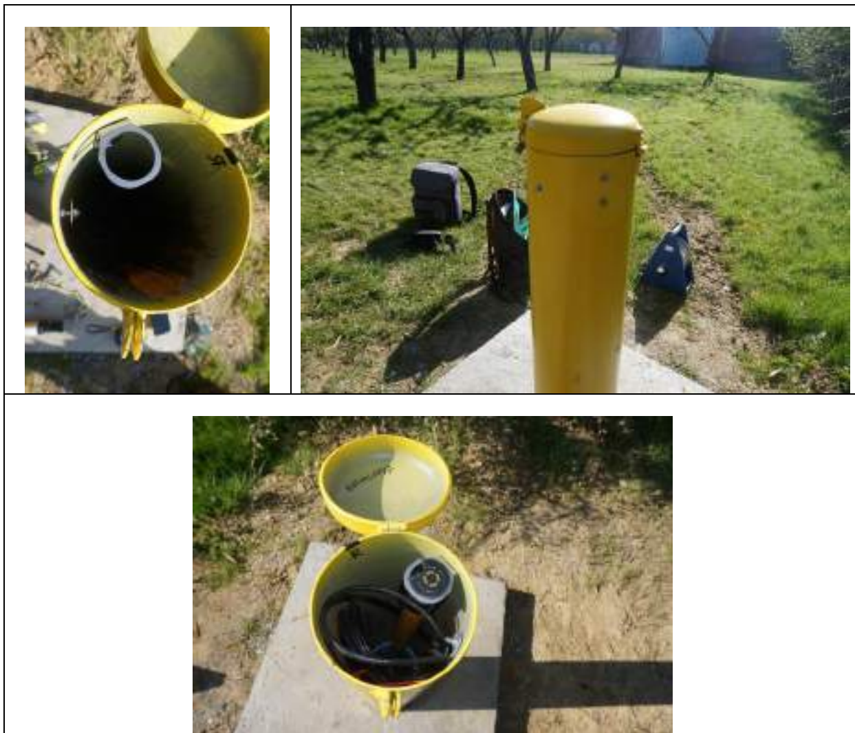
Illustration 19 – Installation de la sonde sur le point BSS004DFVG (Donzac, commune de Donzac)
