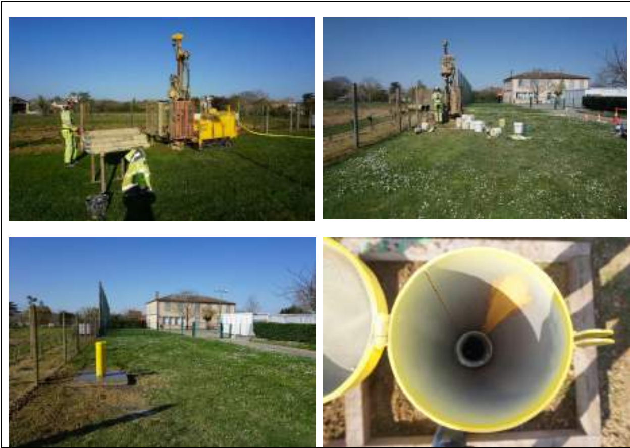
Illustration 12 – Réalisation du forage BSS004DFVP - Savenès
